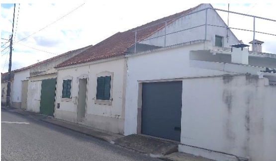
Fotos 13 a 15: Edifícios a necessitar de intervenção
