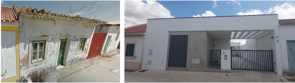
Fotos 53 (Google Maps) e 54: Edifício demolido dando lugar a nova construção
