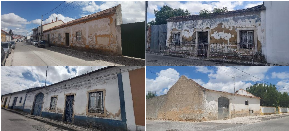
Fotos 16 a 19: Edifícios em avançado estado de degradação
