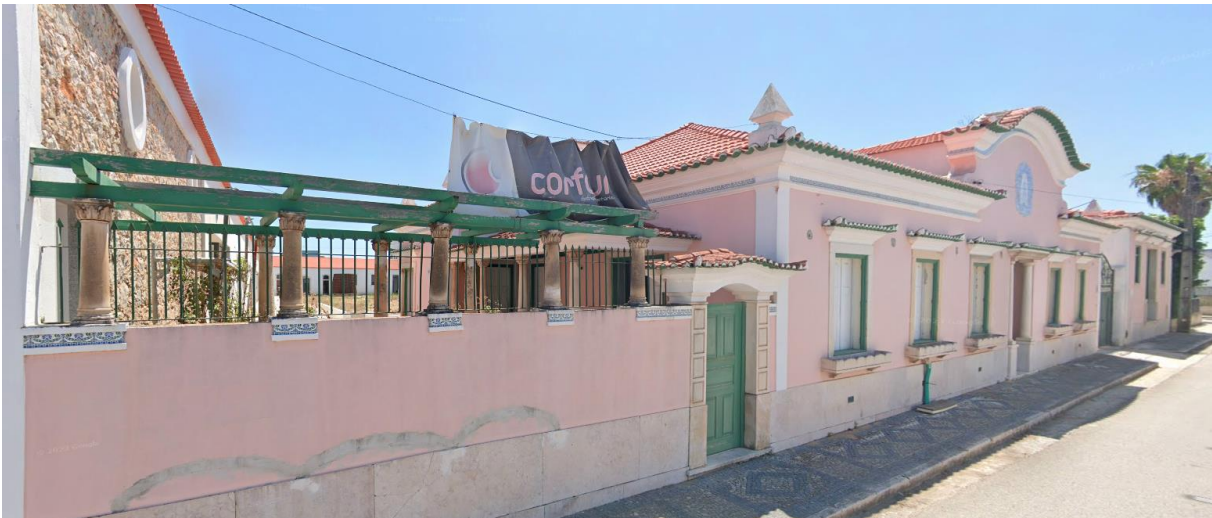
Foto 52: Edifício com interesse arquitetónico, localizado na Rua Mariano de Carvalho, com projeto de arquitetura aprovado em maio de 2018, destinado a equipamento hoteleiro. Edifício sujeito a obras de reabilitação, sem que tenham as mesmas sido concluídas por parte da requerente. O edifício encontra-se há vários anos na presente situação.
