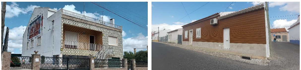
Fotos 24 e 25: Descaracterização de edifícios, através da utilização de materiais
